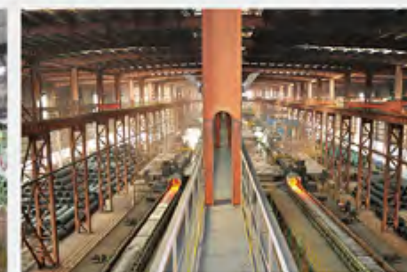
年产 130 万吨双高线总包工程
